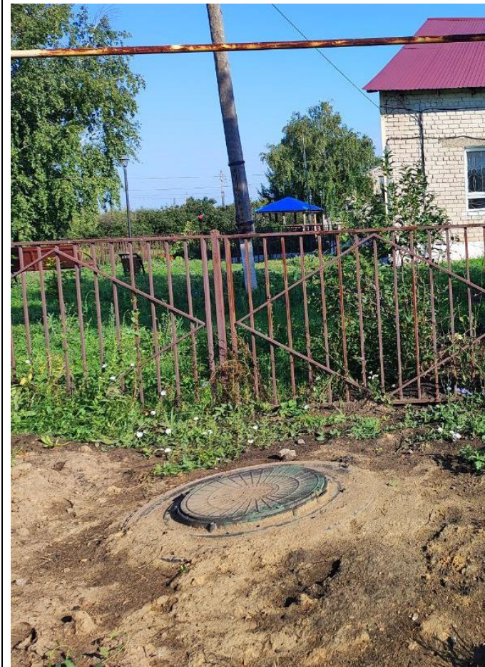
Фото после (люк канализации)
